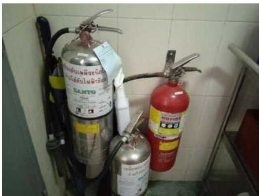
ภาพที่ 21 ถังเคมีดับเพลิง
