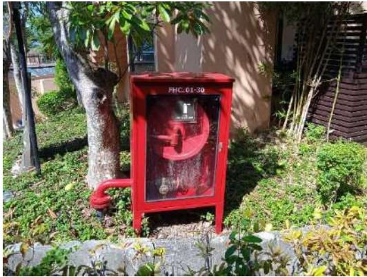
ภาพที่ 19 ตู้เก็บอุปกรณ์ดับเพลิง
