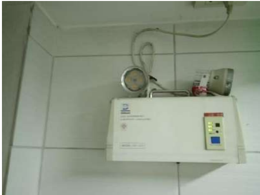
ภาพที่ 13 ไฟส่องสว่างฉุกเฉิน
